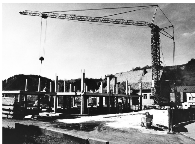
Po asanácii ateliéru Viktora Hermélyho bola na jeho mieste vystavaná budova obchodu Jednota, záber z výstavby (80. roky 20. storočia), novostavba necitlivo zasiahla do historickej zástavby mesta Kremnica
