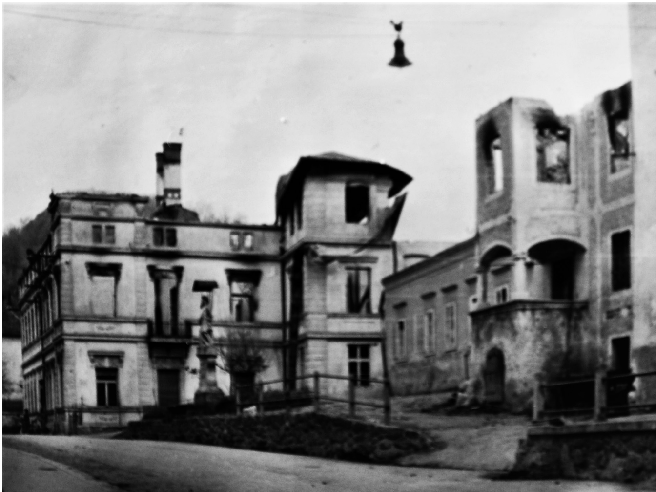
Po požiarí v roku 1945 zničená budova Remenárky v Hornej ulici v Kremnici, vedľa nej stál historický objekt so zaujímavým schodiskom s arkierom, oba objekty dnes už neexistujú, NBS – MMM Kremnica
