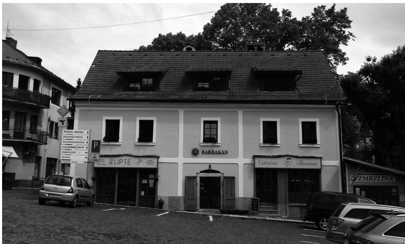
Dom na námestí SNP (č. 37/3) v Kremnici (penzión Barbakan), dom je národnou kultúrnou pamiatkou – jeden z pozitívnych príkladov obnovy pamiatky (strecha patinuje, vikiere nie sú predimenzované, historické prvky sú zachované, vytvorenie kamenného sokla, vizáž výkladov je ako na začiatku 20. storočia; otázne je iba použitie nových kovových okien a modernej štruktúry omietky)
