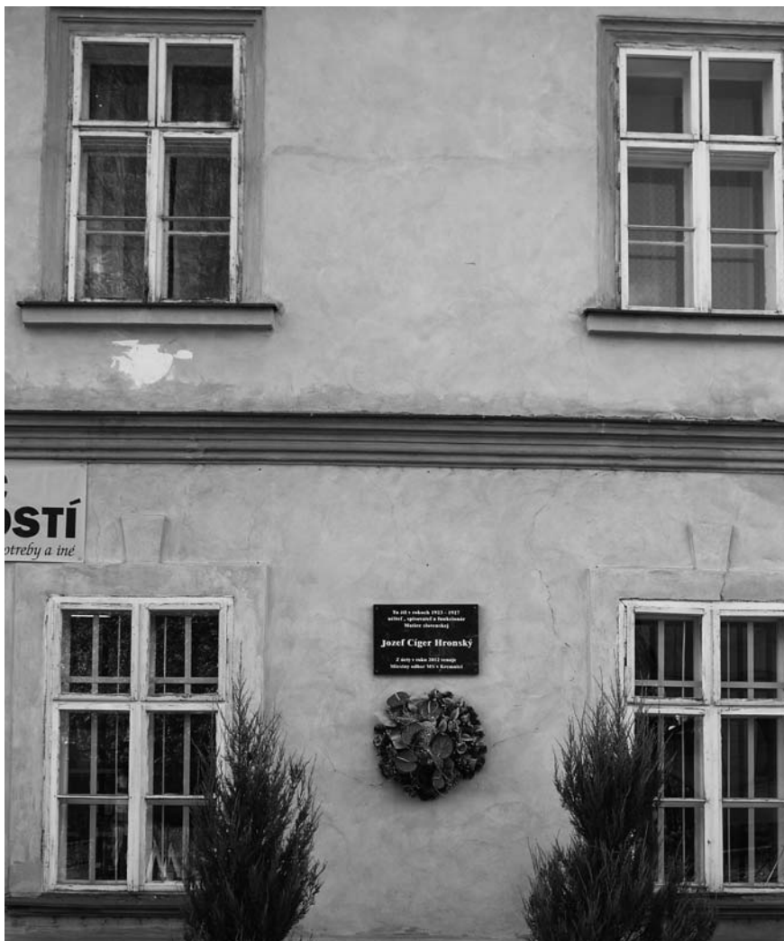
Pamätná tabuľa Jozefa Cígera Hronského na dome na Dolnej ulici v Kremnici, kde býval medzi rokmi 1923 - 1927, foto: DHK, 2018
