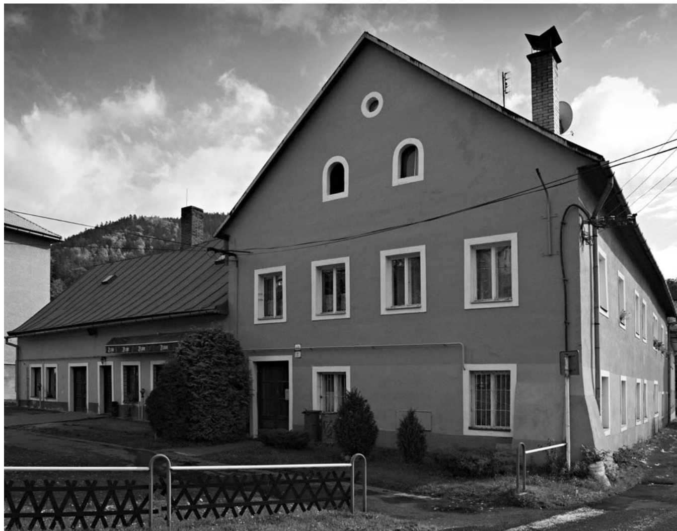
Bývalá továreň na fajky a šamotové kachle Stiasny E. a syn v Kremnici fotografia z roku 2018, foto: DHK
