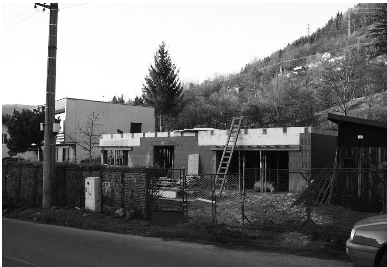
Vznikajúca novostavba v priestore bývalého Kapustovského domu (celkom mimo pôdorysu pôvodného domu! a bez žiadneho vzťahu k okolitej historickej architektúre!)
