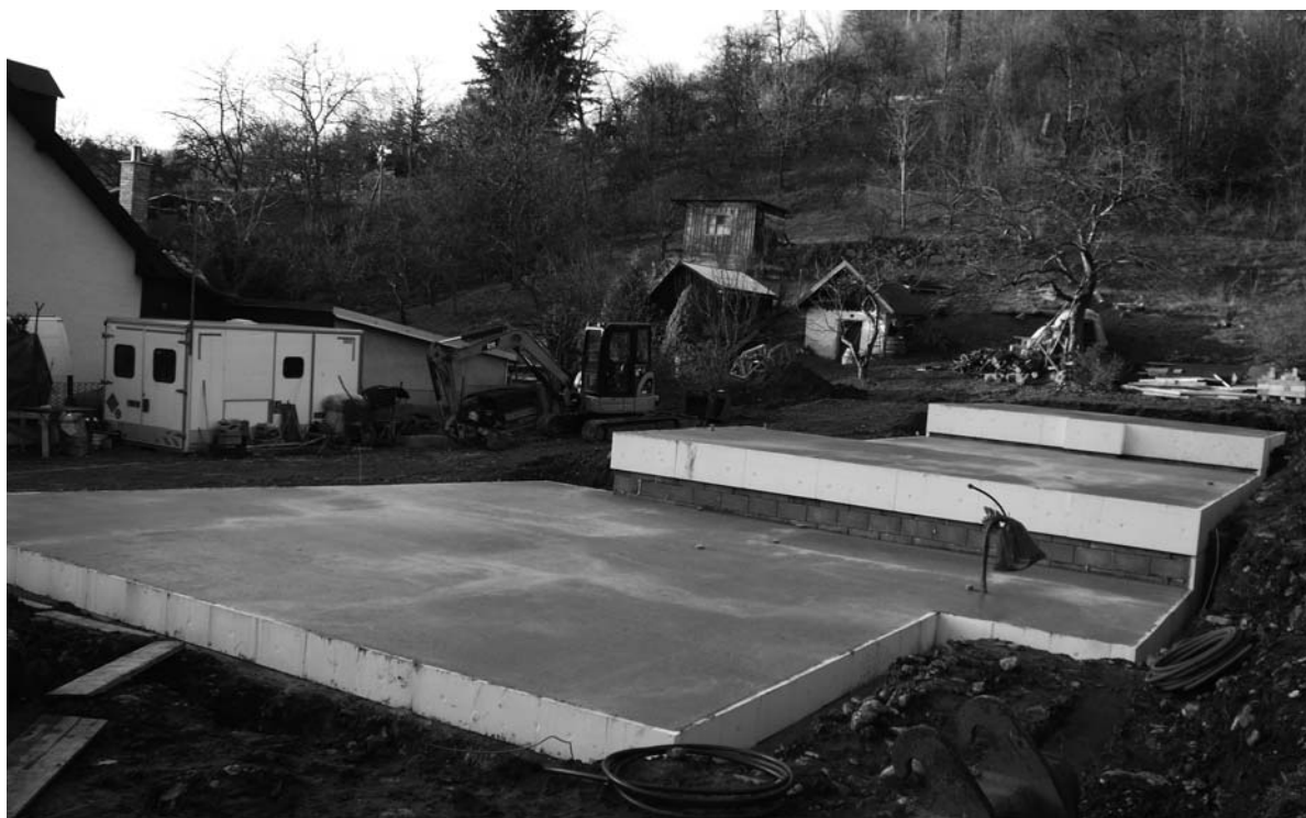
Zbúranisko po asanovaní pôvodného domu a základy novej stavby
