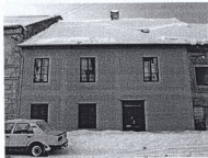
Dom na Kutnorského ulici č. 11, komplexná obnova fasády
