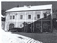
Dom na Kutnorského ulici č. 8, čistočná obnova fasády
